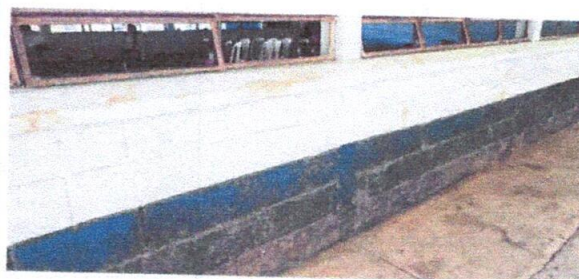
Foto 4: Al inspeccionar las aulas, se observa que las paredes presentan acumulaciones de barro y lodo en varias zonas, resultado de la actividad diaria de los niños durante el recreo y los juegos en exteriores.
